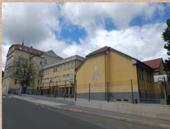
30. 7. 2023, na desni strani nova košarkarska površina (2022)
