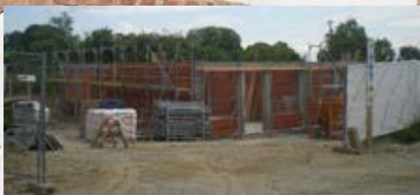
Gradnja novega vrtca, junij 2013
