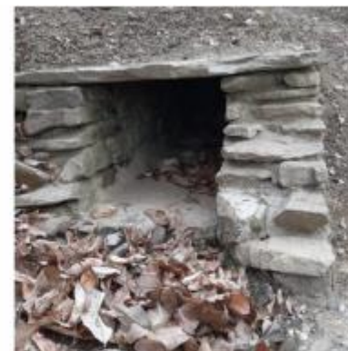
Verodostojna rekonstrukcija podzemeljskega kanala rimskega vodovoda
